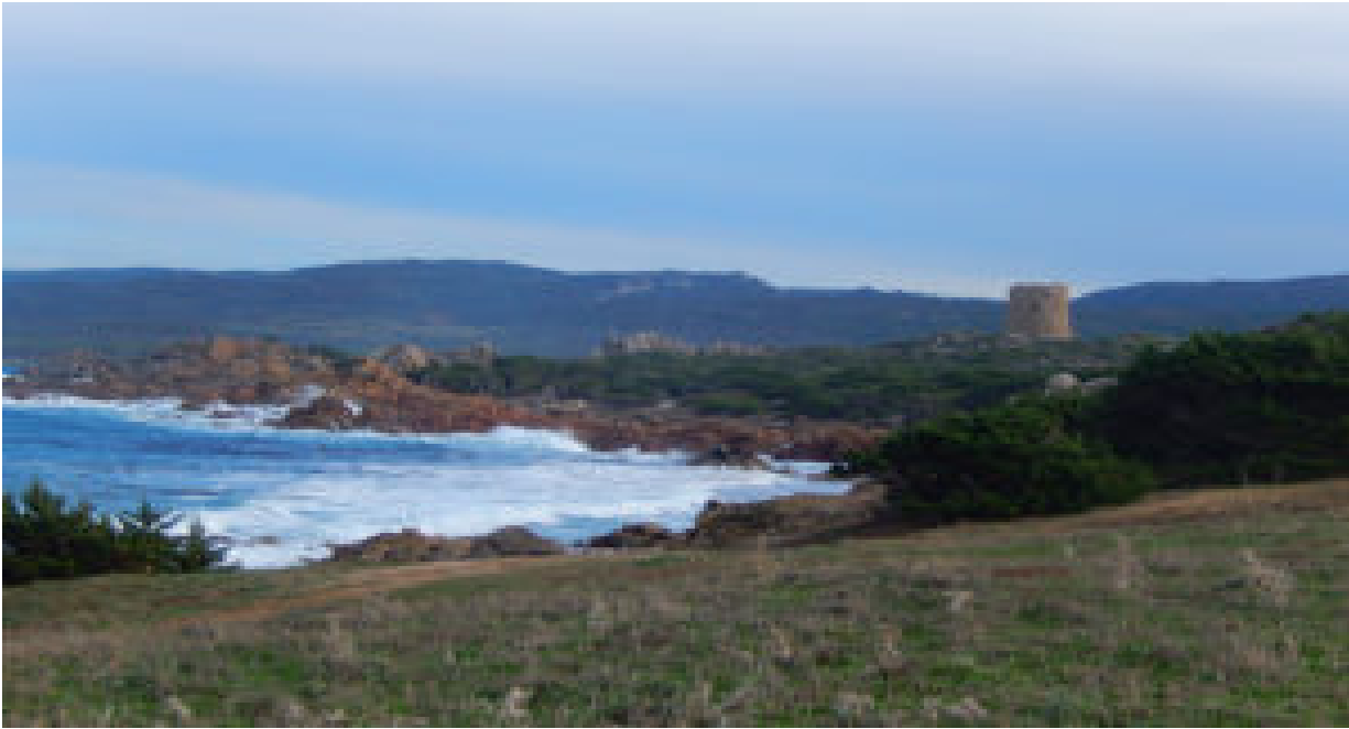
Foto 6. La torre di Vignola
